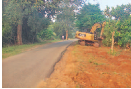
జిడ్డంగి గ్రామశివారున రోడ్డు పనులను చేస్తున్న దృశ్యం
